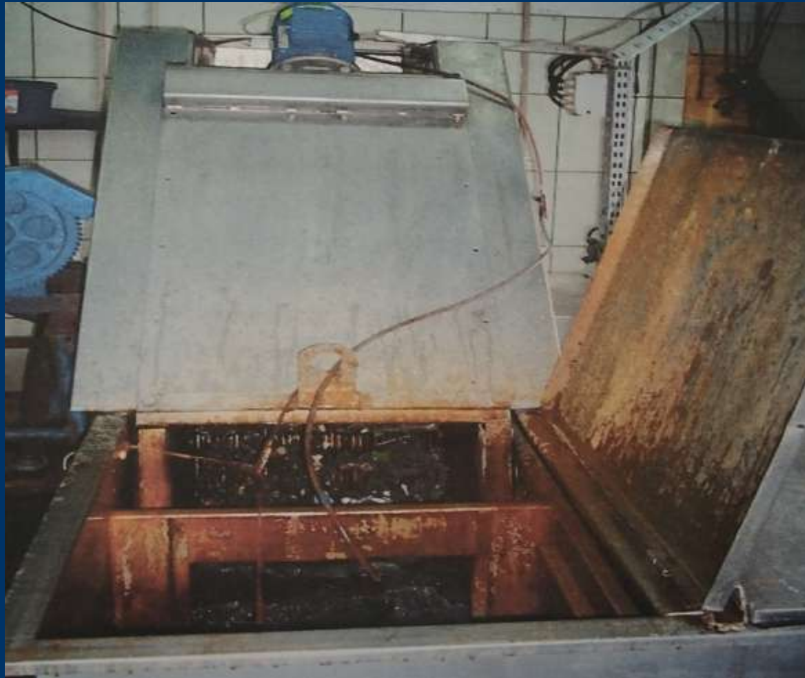
Krata mechaniczna schodkowa
