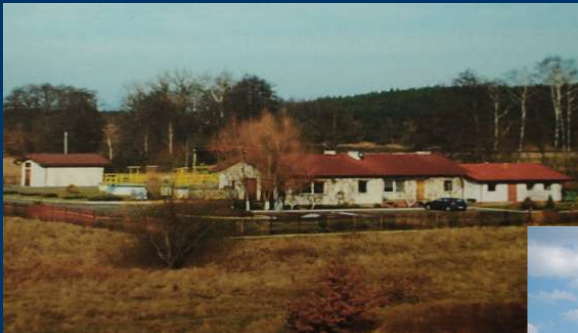
Oczyszczalnia ścieków przed rozbudową
